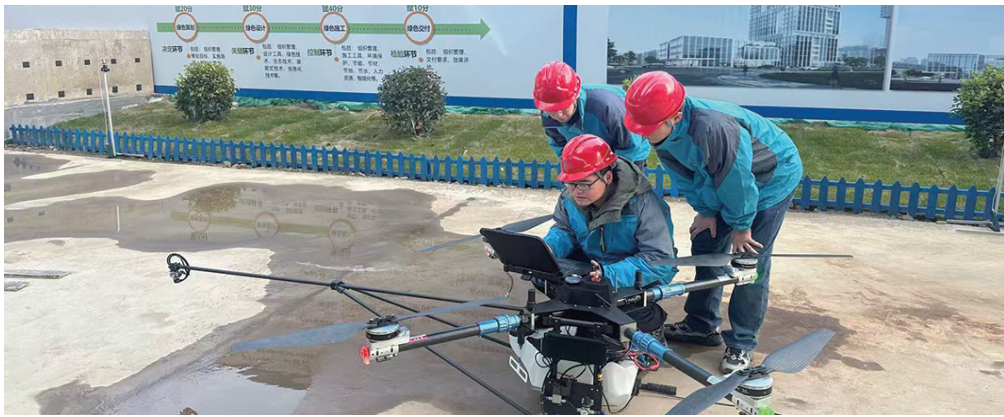
团队在施工现场开展无人机喷涂作业
